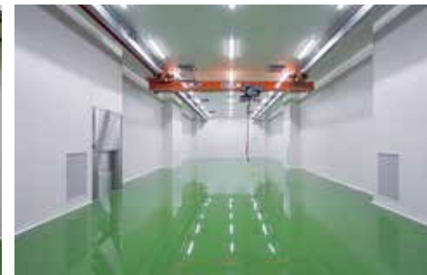
1階クリーンルーム2*
